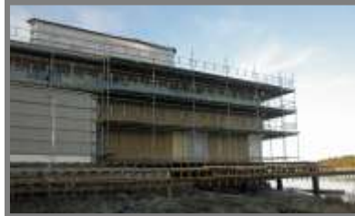
Byggplatsen i slutet av mars 2012
